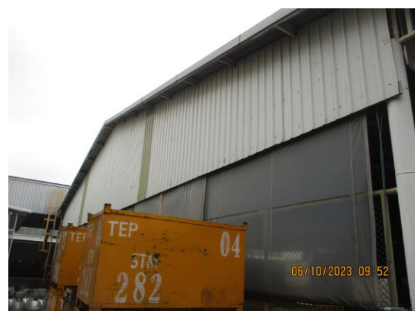
รูปที่ 11 กันสาดผ้าใบบริเวณอาคารกักเก็บขยะ และกากของเสีย
