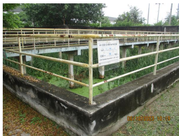
รูปที่ 8 บ่อพักน้ำเสียหลังผ่านการบำบัด
